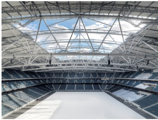
Figur 4.5.a. Takkonstruktionen i Friends Arena är delvis tillverkad i höghållfast stål och vikten har kunnat minska med 584 ton till 4 000 ton.
